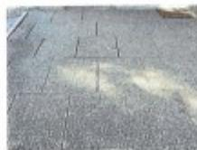
Die auf dem Vorplatz verlegten Waschbetonplatten sind teilweise lose, niveaungleich, unansehnlich, unpassend.
