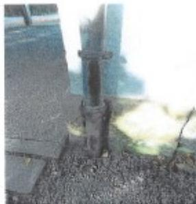
Der Dachablauf geht direkt ins Gelände. Ein weiterer führt ins Erdreich und ist völlig verstopft so dass Wasser ausläuft ins Mauerwerk => Abflüsse neu verlegen
