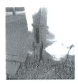
n Dachablauf geht direkt ins Gelände. Ein weiterer führt ins Erdreich und ist völlig verstopft so dass Wasser ausläuft ins Mauerwerk => Abflüsse neu verlegen
